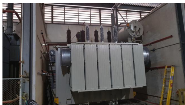
Ilustración 10. Suministro e instalación del transformador de potencia en la central eléctrica de Jinámar
