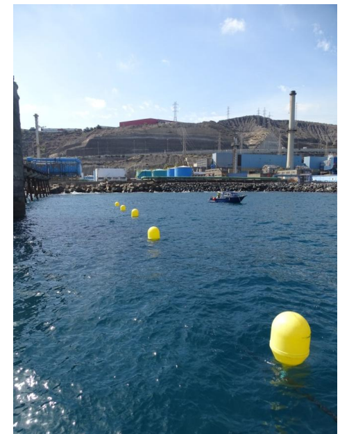
Ilustración 7. Inicio del tendido
