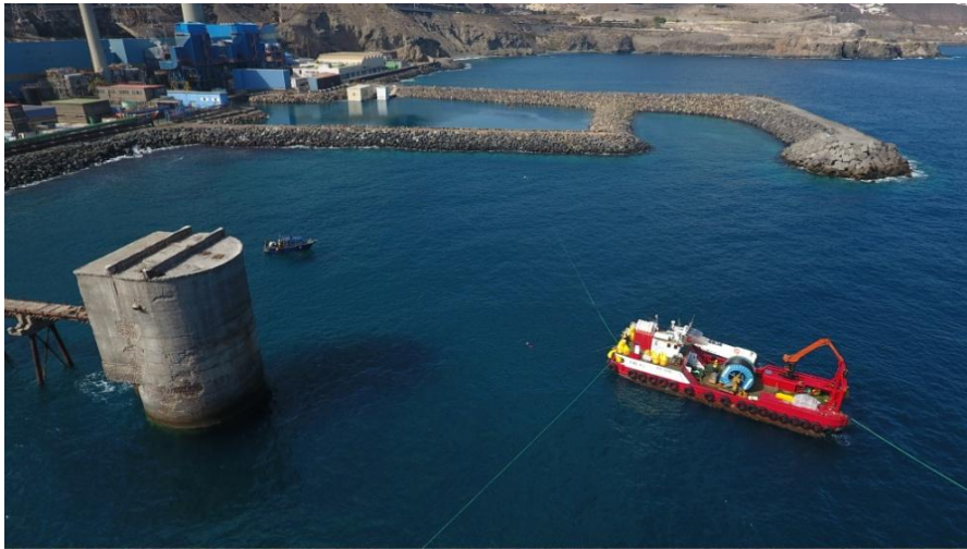
Ilustración 4. Fondeo del barco cablero para iniciar las operaciones de instalación
