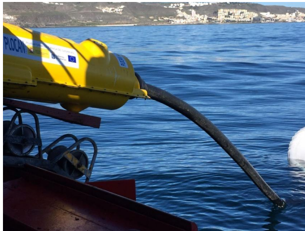
Ilustración 5. Tendido del empalme
