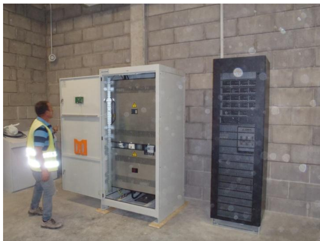
Ilustración 57. Módulo de alimentación en la plataforma
