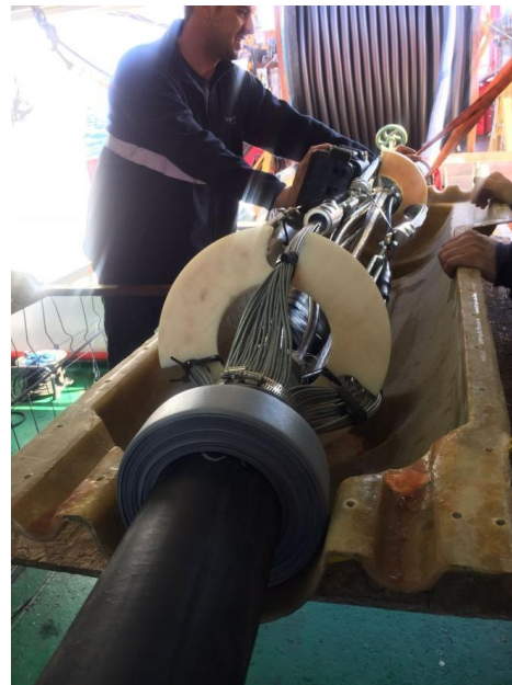
Ilustración 6. Confección de empalme
