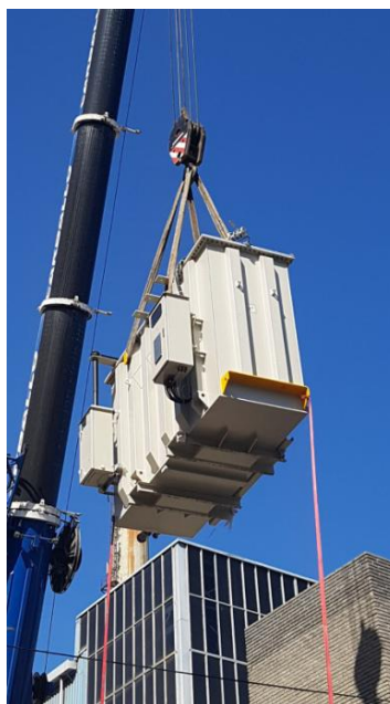
Ilustración 10. Suministro e instalación del transformador de potencia en la central eléctrica de Jinámar
