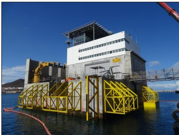
Ilustración 18. Estructuras estabilizadoras en fase de
