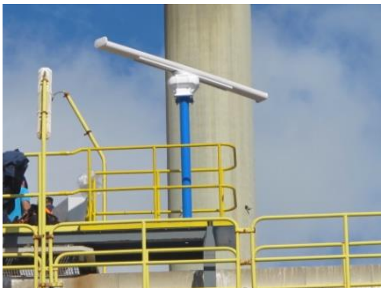
Ilustración 31. Antena radar del sistema VIPICUL
