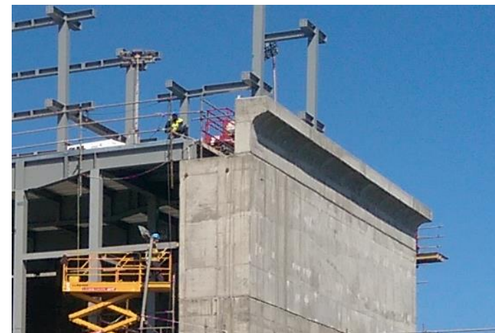
Ilustración 4. Detalle de ejecución del botaolas a la +17,80
