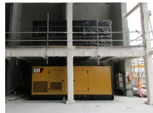
Ilustración 15. Grupos electrógenos
