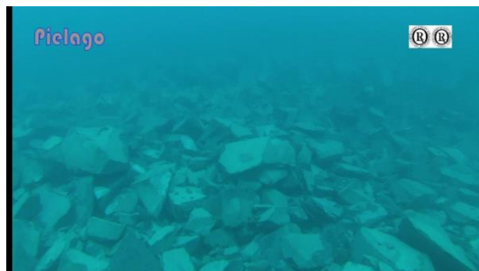
Ilustración 34. Banqueta sobre el fondo marino
