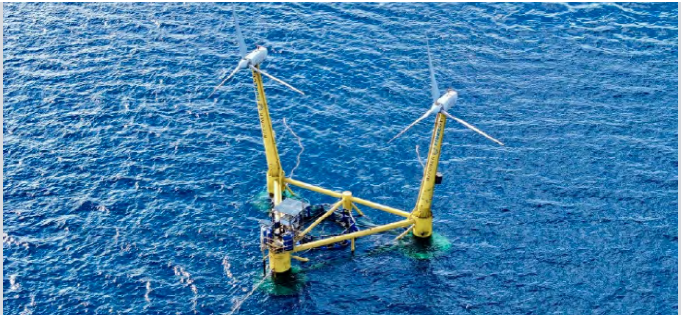
Ilustración 5. Fondeo del prototipo de Aquawind en el banco de ensayos de PLOCAN
